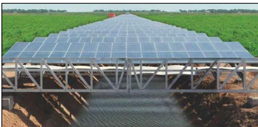
*Fig. 5: Ejemplo de instalación sobre canal.*
